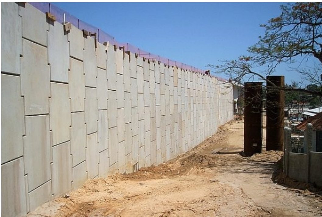
Figura 17.6: Vista frontal de um muro finalizado
