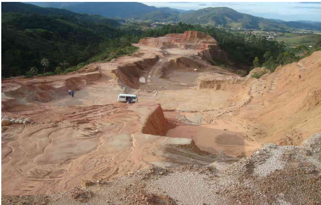
Figura 6.11 - Visão geral da caixa de empréstimo Verde Vale
