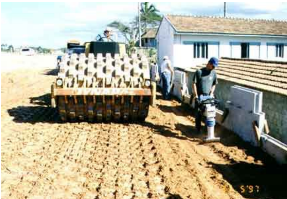
Figura 17.4: Detalhe da compactação manual e mecanizada
