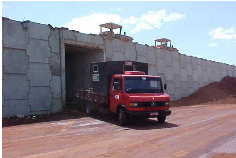
Figura 17.5: Vista de uma obra em Terra Armada em final de execução
